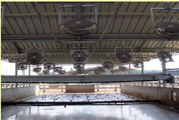
写真3 床からの水の噴射と送風、上部ノズルからは水滴、上部および側壁のファンから送風。パーラーに入る前に水で濡らして冷やし、送風で乾かす。
