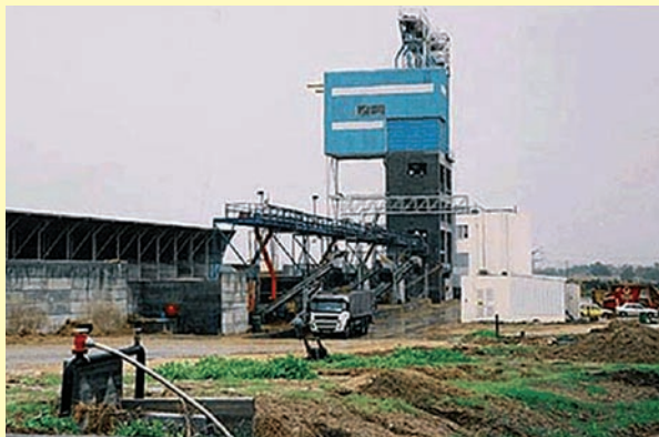
写真4 イスラエル最大の TMR センター
